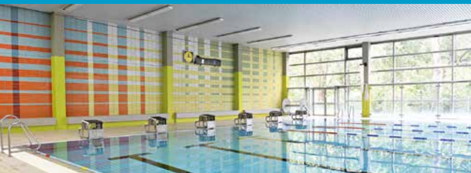
Inzwischen ist das Wasser raus. Das Stadtbad Charlottenburg muss instandgesetzt werden.
