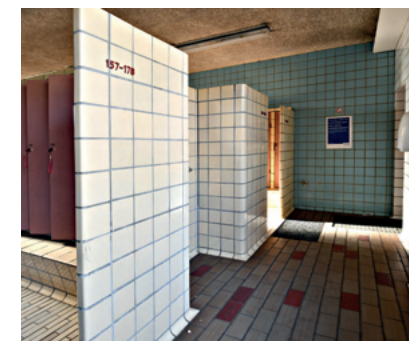
Die Umkleiden im Paracelsus-Bad stehen wie vieles andere im Bad unter Denkmalschutz. Sie bleiben in ihrer Form erhalten.
