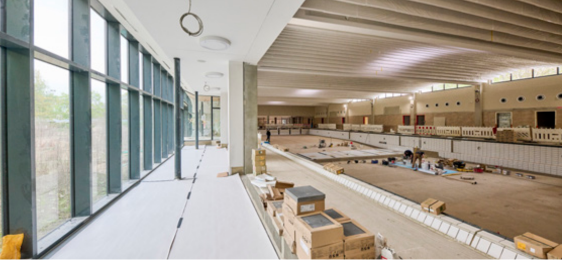
Durch den neugeschaffenen Wintergarten mit Glasfront wird die Halle größer. Hier gibt es jetzt mehr Platz für Liegestühle.
